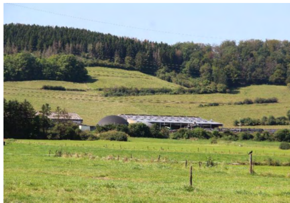
Figure 117 : Installation de biométhanisation à Mullendorf (Photo Luxplan 2021)
