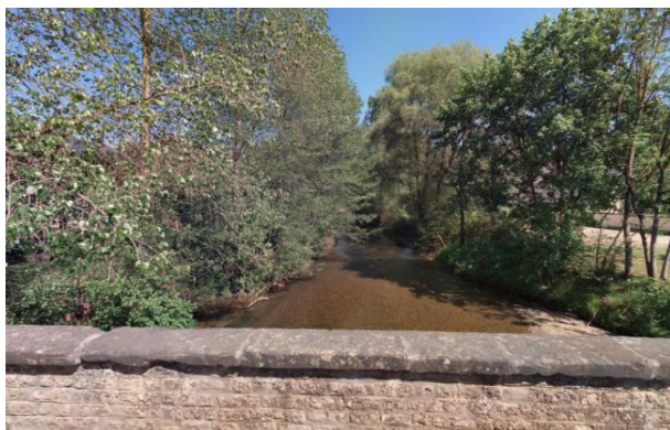
Figure 108 : Vue sur l'Atert à Everlange (Photo Cyclomedia Street Smart)
