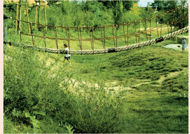
Abb. 6.16 Regenrückhaltung im Quartier Versickerungsanlage Beispiel Bad Dürkheim 34 rechts: Versickerungsmulde in einem Spielplatz 35
