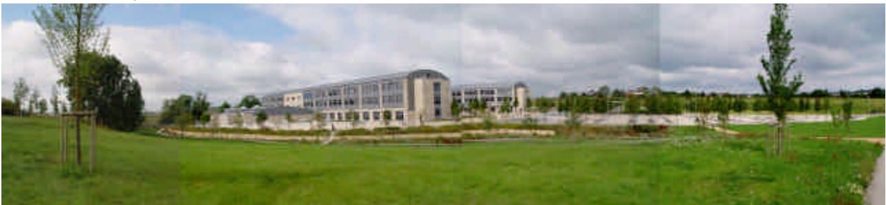
Vue partie basse vers Lycée technique Josy Barthel ( photos Hegelmann Dutt Kist)
