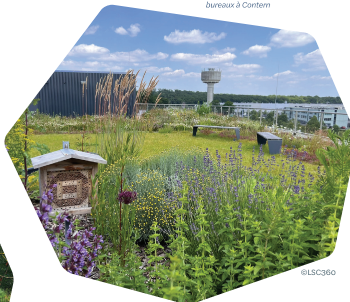
Toiture végétalisée d'un bâtiment de bureaux à Contem
