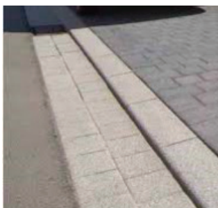
Grille d'évacuation avant une rampe d'accès à un parking souterrain
