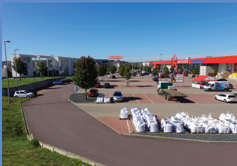
Parking existant à Capellen
