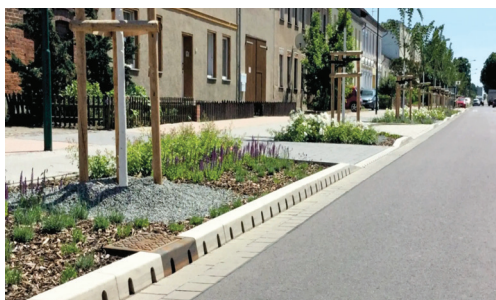
Cunette en bordure de voirie et bordure de trottoir facilitant l'évacuation
