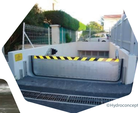
Grille d'évacuation avant une rampe d'accès à un parking souterrain
