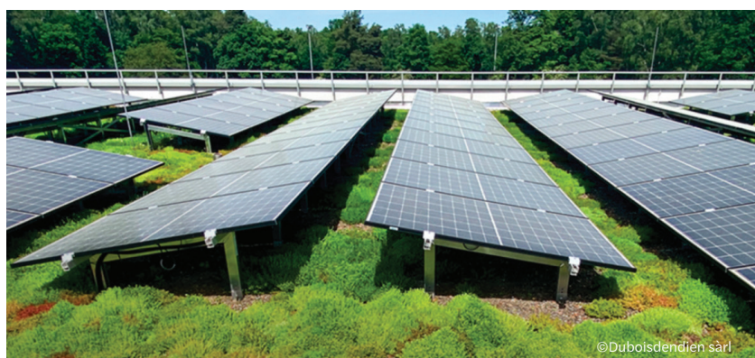
Toiture végétalisée munie de panneaux photovoltaïques à Differdange
