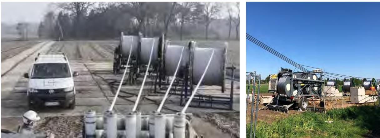
Abbildung 21: Seilzuganlagen. Quelle: [www.cteam.de](http://www.cteam.de) (links), [www.tennet.de](http://www.tennet.de) (rechts)
