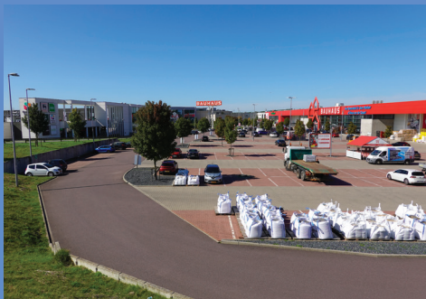
Parking existant à Capellen
