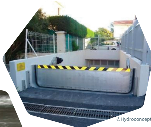
Grille d'évacuation avant une rampe d'accès à un parking souterrain
