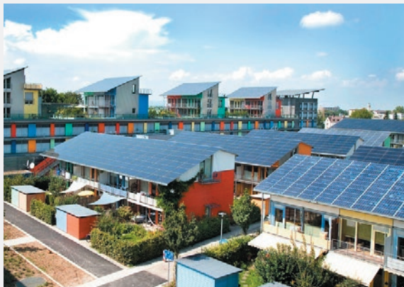
Figure 22 - Vue de la cité solaire du Schlierberg à Vauban
