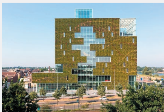
Figure 18 - Façade avant du Venlo City Hall
