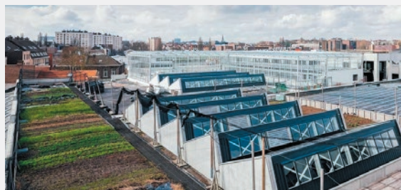
Figure 34 - Vue du toit de la ferme BIGH sur le toit du site de l'Abattoir
