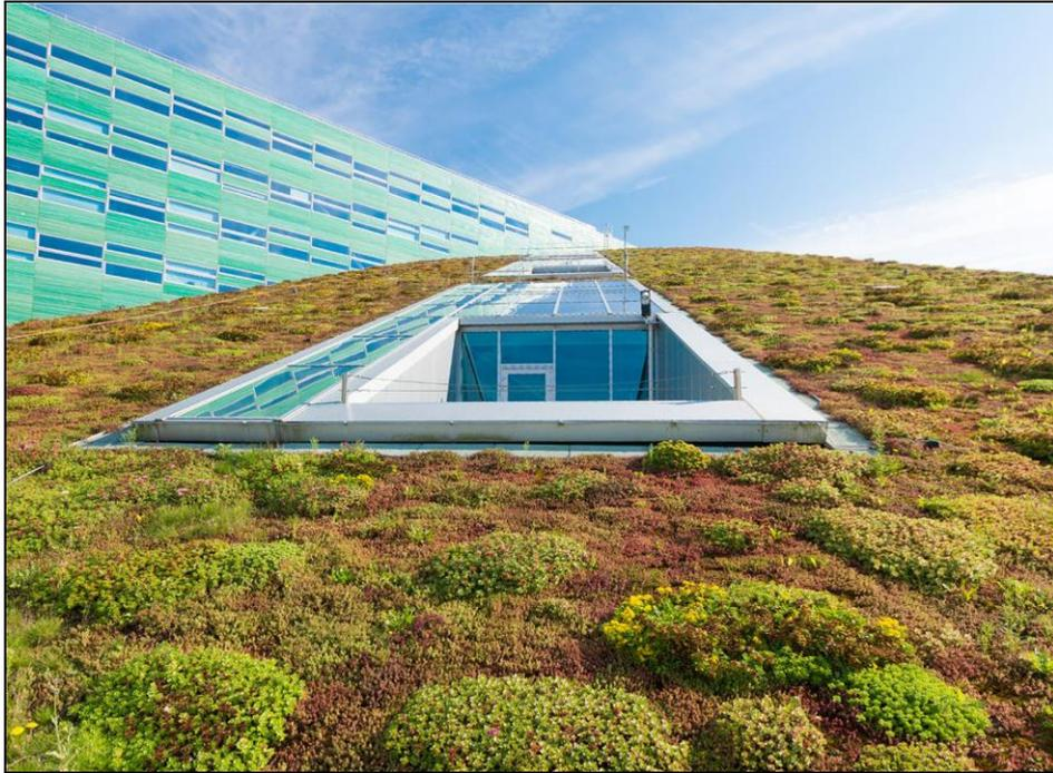
**Photo 7: Exemple d'une toiture verte sur un bâtiment industriel.**
