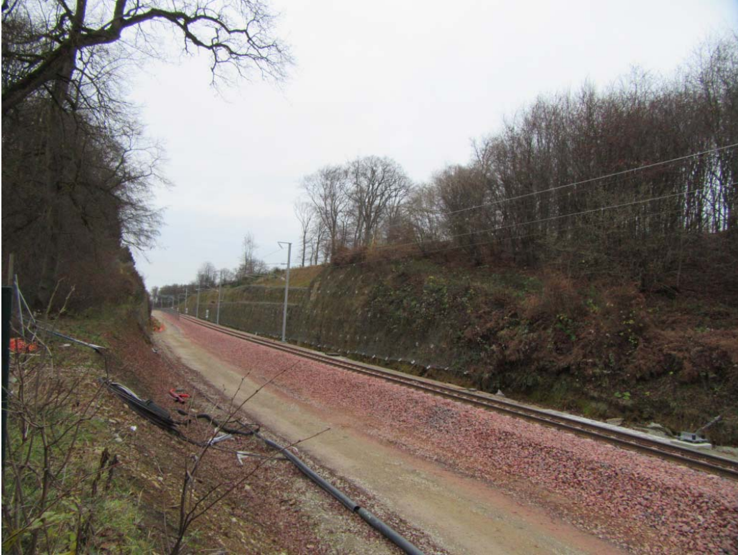
Neubau der Eisenbahnlinie
