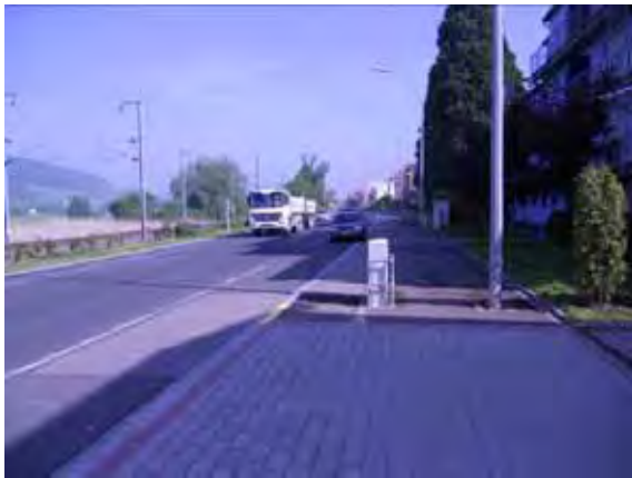
Route Principale: ausreichend breiter Gehsteig
