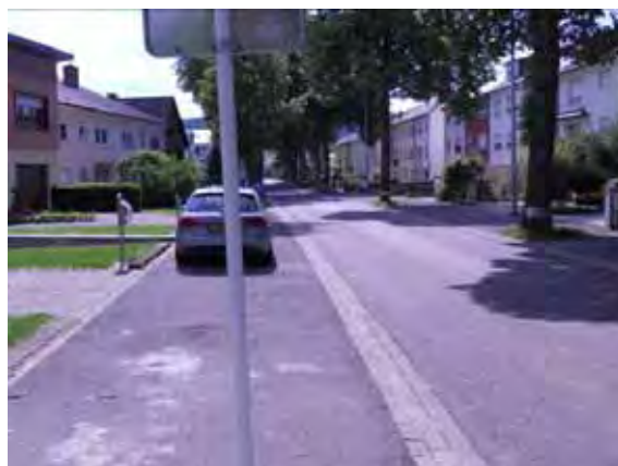
Hünsdorf: Rue de Steinsel: verparkter Gehsteig
