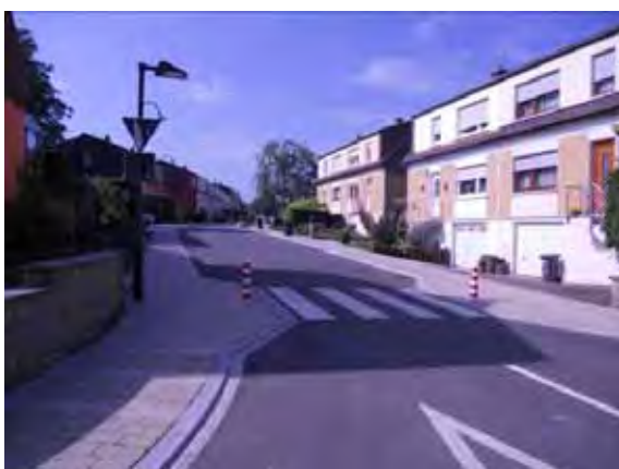
Gute gestaltete Querung mit Vorziehung Rue de l'Eglise
