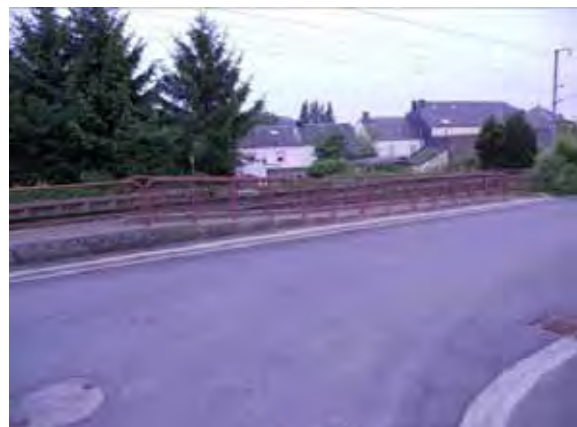
Haltestelle Heisdorf: barrierefrei, Absenkung der Gehsteigkanten erforderlich
